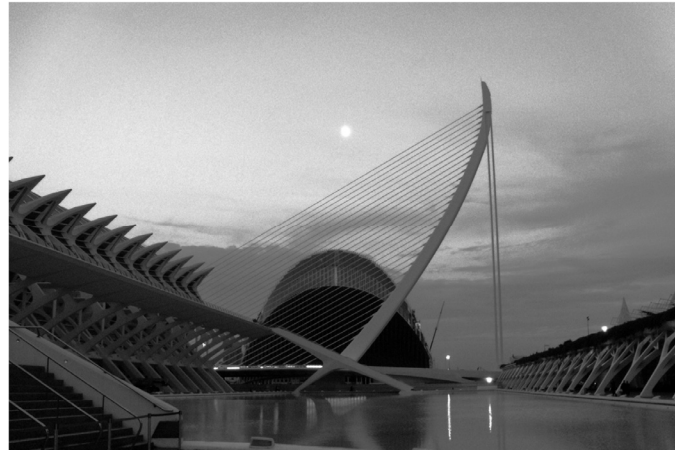
Santiago Calatrava - Serreria Bridge - Valencia 2008
